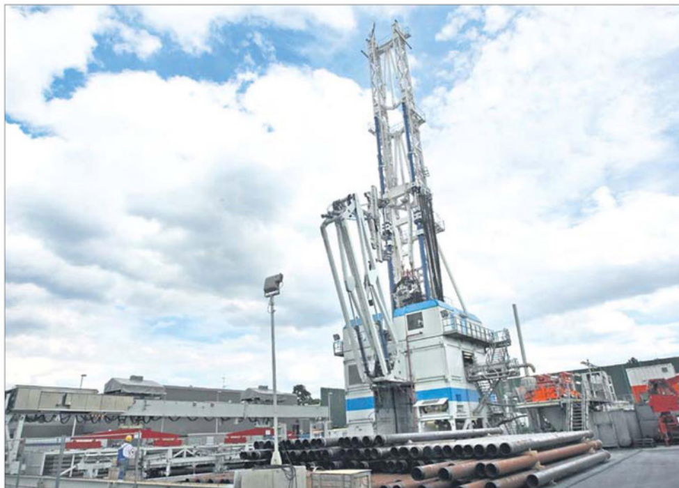
4000 Meter tief in die Erde: In Hannover bohren Wissenschaftler nach 130 Grad heißem Wasser.
